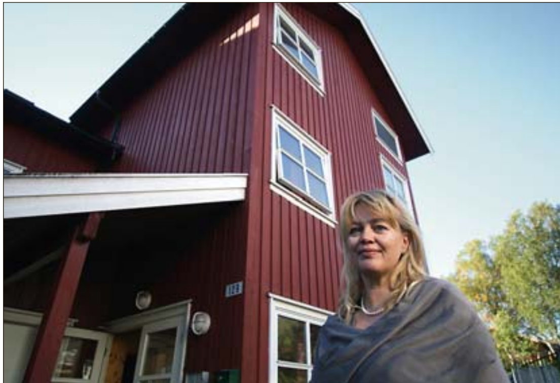
DYRT: Arbeidet med å restaurere Solplassen i Narvik etter vannlekkasjen, er begynt. Daglig leder Kirstin Leiros i Narvik Boligstiftelse må belage seg på et omfattende arbeid.
